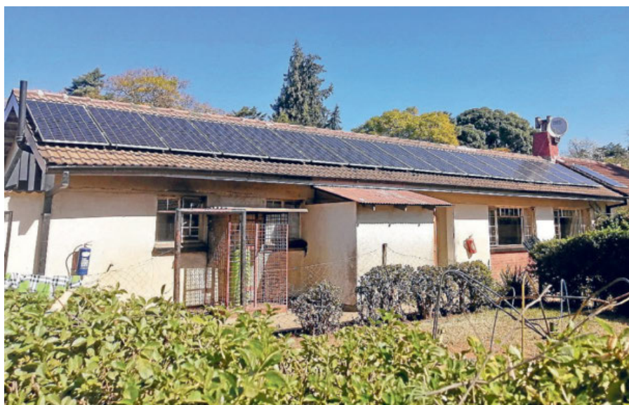
Eines der Vorzeigeprojekte: die Grundschule von Hozheri. Sie verfügt über eine Photovoltaikanlage und einen Wasseranschluss, hat einen Schulgarten und einen Spielplatz.
